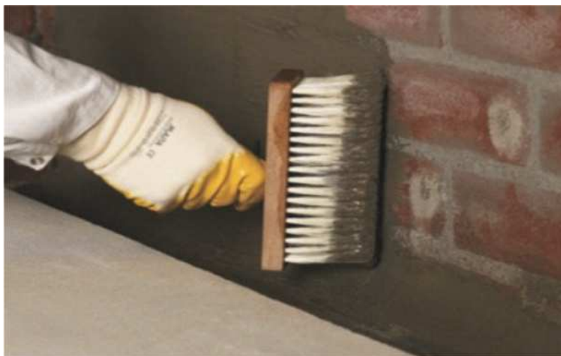
Obr. Cementová stierková hydroizolácia MC Proof 601 HT s vyvedením skrz nábehový fabión
